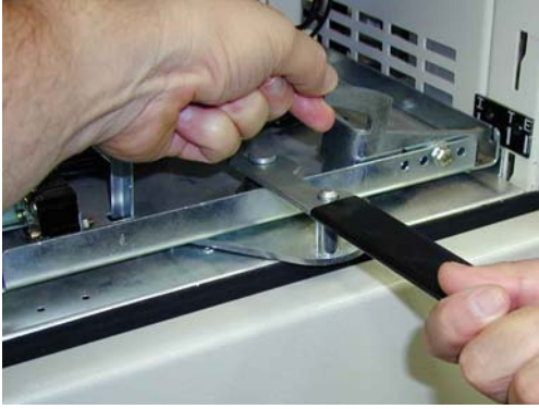
Blokset Mw tipi çekmece montajı Blokset type Mw Drawer insertion
