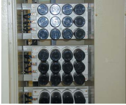
Blokset D tipi - arka yüz Blokset type Dc - rear face
